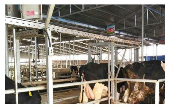
所有线缆走线槽,禁止与动力线 (220以上电源线) 走同一线槽,尽量远离干扰源 (变频设备,高压线等)
