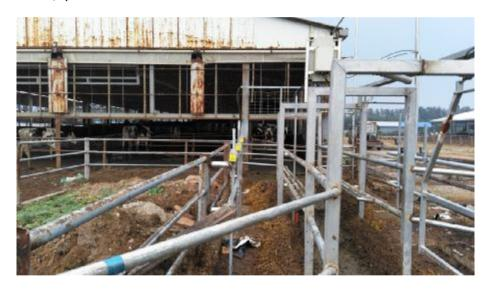
光电开关安装到分群门以外50cm, 横梁加密, 避免牛碰到
