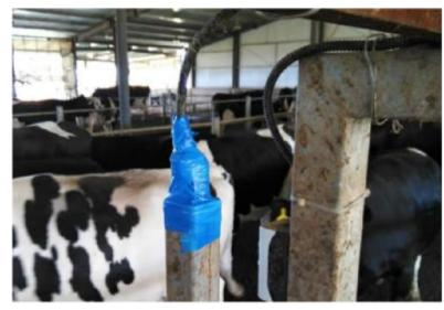
控制箱下方安装遮板避免牛舔,或将控制箱安装到其他地方
